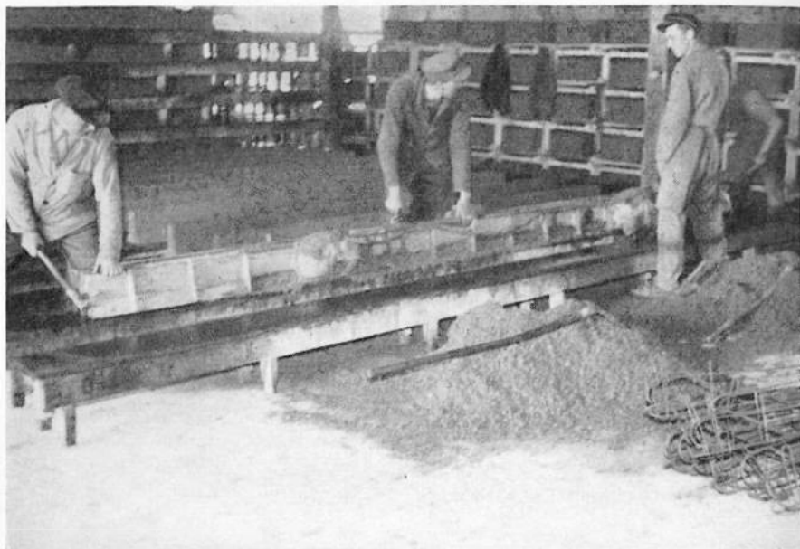
Im Betonwerk Heringen werden Deckenträger hergestellt
