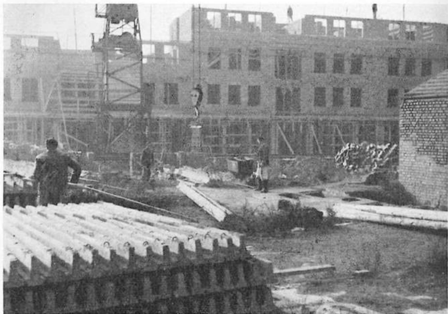
Die Deckenträger finden beim Aufbau unserer Kreisstadt Verwendung
