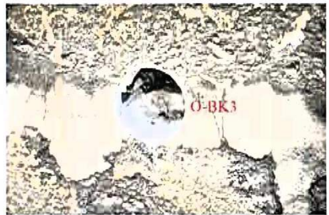
Bilder A2.6 und A2.7: Entnahmestelle der Bohrkernprobe O-BK3: Unmittelbar unter der Verfugung mit einem zementhaltigen Mörtel steht Gipsmörtel an. Als Abstandshalter sind Schieferstücke vorhanden.
