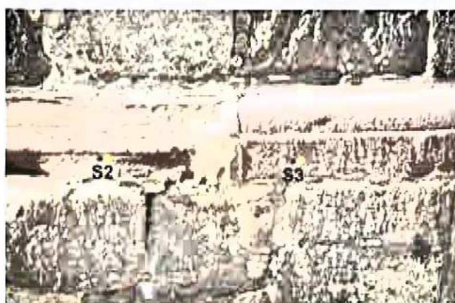
Bilder A1.6 bis A1.8: Probenahmestellen O-S2 und O-S3 in Sandsteinen des Sockelabschlusses – siehe auch Bild A1.1:
