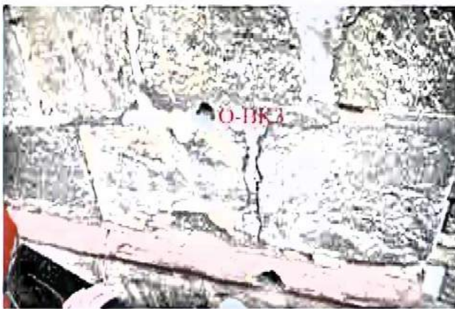
Bilder A2.6 und A2.7: Entnahmestelle der Bohrkernprobe O-BK3: Unmittelbar unter der Verfugung mit einem zementhaltigen Mörtel steht Gipsmörtel an. Als Abstandshalter sind Schieferstücke vorhanden.
