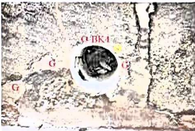
Bilder A2.8 und A2.9: Entnahmestelle der Bohrkernprobe O-BK4: Die Probenahmestelle wurde gewählt um den Kalkstein zu beproben. Während der Bohrung stellte sich heraus, dass es sich um ein sehr heterogen verfülltes Loch, das an der Oberfläche sehr gut mit Mörtel und Steinmaterial retuschiert ist, handelt. Möglich ist hier die Verfüllung eines ehemals als Gerüsthaltung verwendeten Loches im Mauerwerk.
