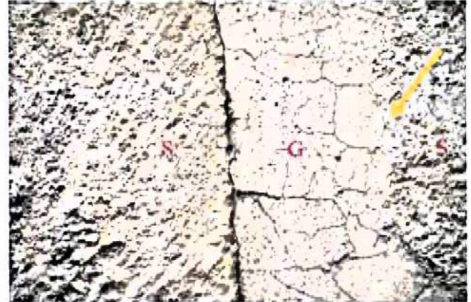
Bilder A2.22 und A2.23: Weiterer Wandbereich mit Gipsmörteln („G“) in Fugen an der Wandoberfläche: Die Mörtel dienen auch zum Abgleich der Wandoberflächen an den Steinkanten („S“) (Pfeil).
