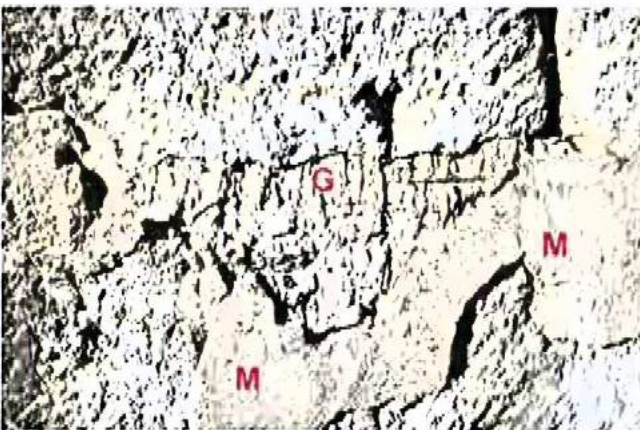
Bild A1.44: Wandfläche über dem zuvor genannten Bereich: Unter dem abschalenden zementhaltigen Mörtel („M“) wird ein Gipsmörtel, der trotz Anwitterung noch mit den Steinkanten abschließt, sichtbar.
