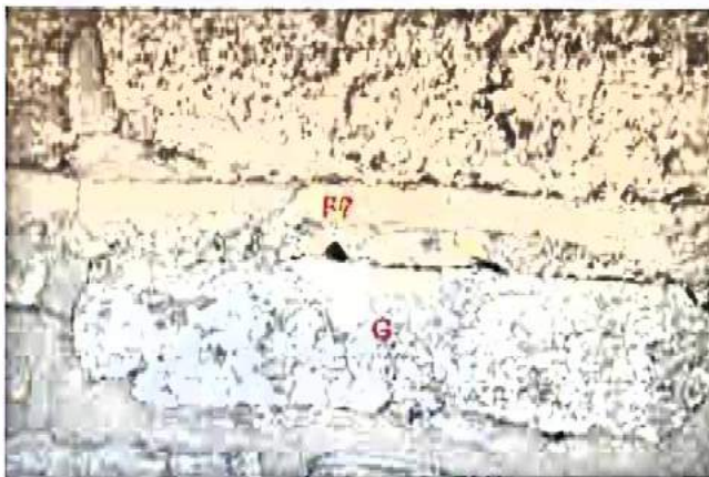
Bild A1.27: Probenahmestelle O-F7 („F7“) in der Fuge unmittelbar unter dem Dachgesims. Das Steinmaterial des Dachgesimses unterscheidet sich vor allem in der äußerlich sichtbaren Porigkeit deutlich von den Carbonatgesteinen im restlichen Mauerwerk.
