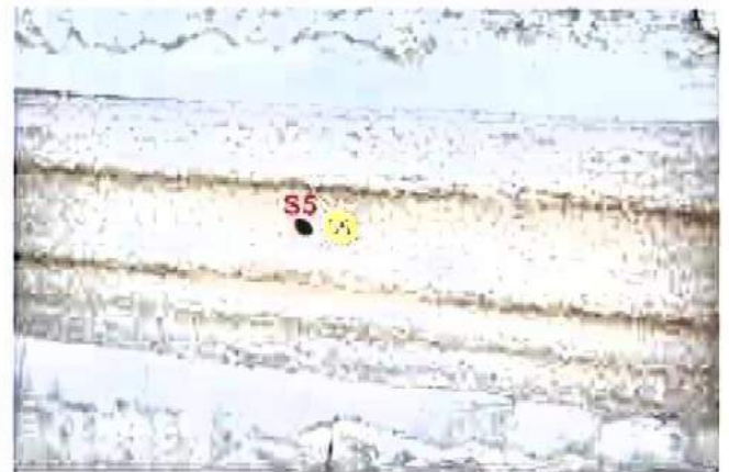
Bilder A1.19 und A1.20: Im Vergleich zur Fuge (Pfeil) aus einem sehr festen zementhaltigen Mörtel sind die Gesimse im Bereich der Probenahmestelle O-S5 („S5“) etwa um 1 bis 1,5 cm zurückgewittert. Die Sandsteinoberflächen neigen zum feinschichtigen Abblättern und zum Absanden.
