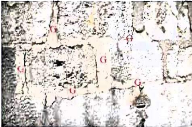
Bilder A2.22 und A2.23: Weiterer Wandbereich mit Gipsmörteln („G“) in Fugen an der Wandoberfläche: Die Mörtel dienen auch zum Abgleich der Wandoberflächen an den Steinkanten („S“) (Pfeil).
