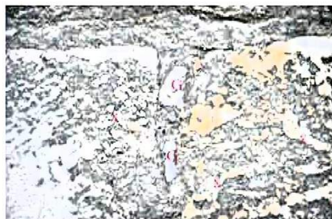
Bilder A1.70: An den Oberflächen der Westfassade ist erkennbar, dass Gipssteine („G“) mit verbaut wurden. Partiiell sind Gipssteinstücke („G“) als Zwickelmateral erkennbar. Ebenfalls sichtbar sind Reste von Glättmörteln (vermutlich auf Gipsbasis, die sich auf einigen Steinoberflächen („x“) befinden.
