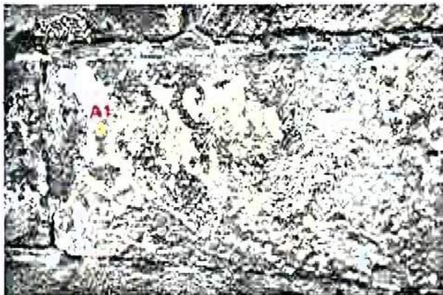
Bilder A1.38 und A1.39: Die Probe S-A1 („A1“) wurde aus der auf der Steinoberfläche aufliegenden und abschalenden Schicht entnommen.
