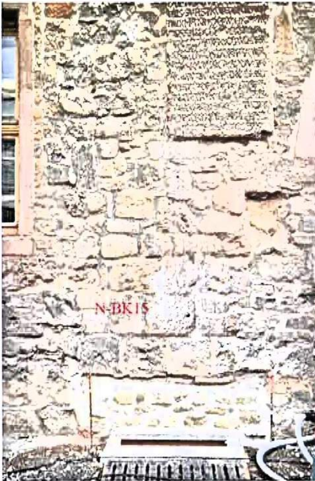
Bilder A2.59 und A2.60: Entnahmestelle der Bohrkernprobe N-BK15 an der Nordfassade: Die Situation ist vergleichbar mit der an den Probenahmestellen N-BK13 und N-BK14.
