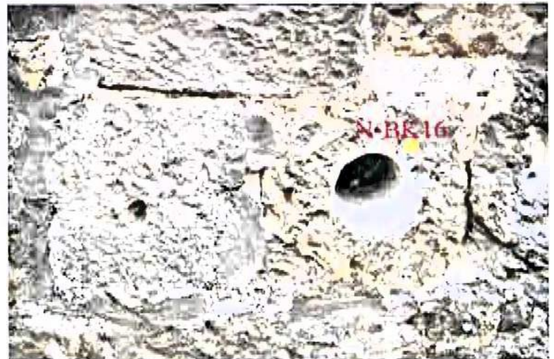
Bilder A2.61 und A2.62: Entnahmestelle der Bohrkernprobe N-BK16 an der Nordfassade: Die Situation oberhalb der Probenahmestelle ist vergleichbar mit der an den Probenahmestellen N-BK13 bis N-BK15.
