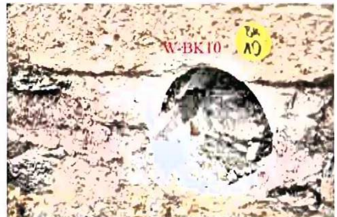
Bilder A2.34 und A2.35: Entnahmestelle der Bohrkernprobe W-BK10: Unter der Verfugung aus zementhaltigen Mörteln befindet sich Gipsmörtel im Mauerwerk. Als Zwickelmaterial im Mauerwerk kamen auch Sandsteinstücke zum Einsatz.
