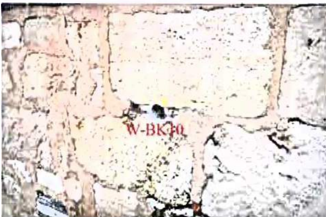
Bilder A2.34 und A2.35: Entnahmestelle der Bohrkernprobe W-BK10: Unter der Verfugung aus zementhaltigen Mörteln befindet sich Gipsmörtel im Mauerwerk. Als Zwickelmaterial im Mauerwerk kamen auch Sandsteinstücke zum Einsatz.
