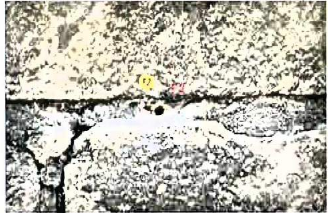
Bild A1.37: Die Probenahmestelle S-F2 („F2“) befindet sich in einer mit einem schwarzen Mörtel verschlossenen Fuge. Hinter diesem Mörtel befindet sich ein weißer Gipsmörtel.
