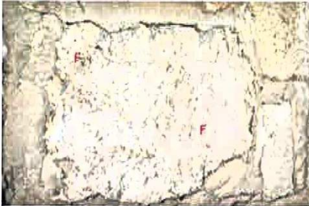
Bilder A1.25 und A1.26: Stein im Wandbereich unter dem schützenden Dachüberstand mit Mörtel- („M“) und Anstrichresten („F“) auf der Oberfläche
