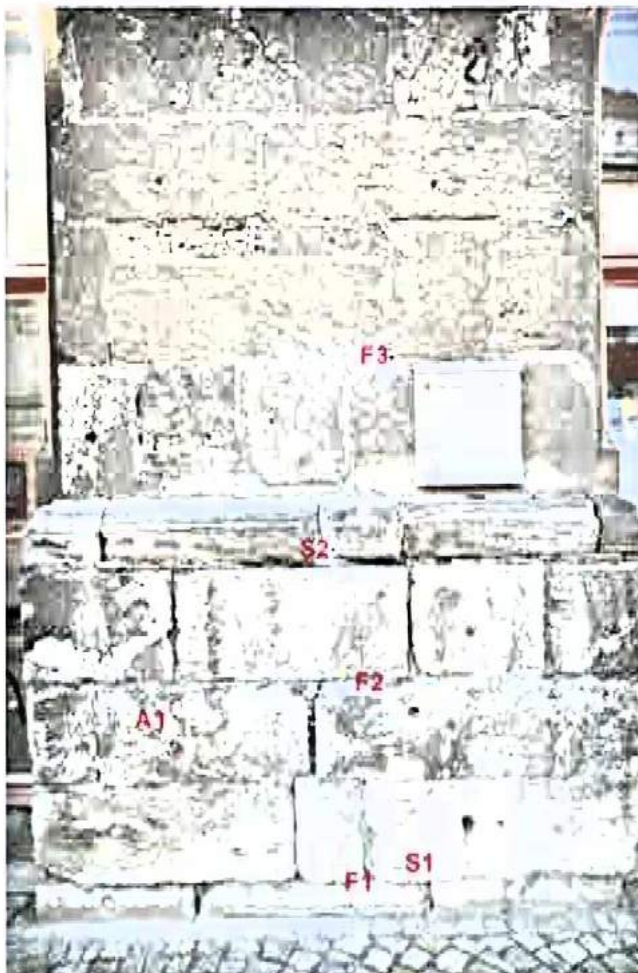
Bilder A1.33 bis A1.35: Übersicht zu Probenahmestellen im Bereich des Sockels und unmittelbar darüber sowie Detailansichten zu den Probenahmestellen S-S2 („S2“) und S-F3 („F3“):
