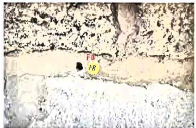
Bild A1.28: Probenahmestelle O-F8 („F8“) in der Fuge unmittelbar unter dem Dachgesims. Vermutlich wurde nach dem 2. Weltkrieg das komplette Gesims mit dem Steinmaterial erneuert. Direkt unter der Probenahmestelle ist ein Gipsstein („G“) verbaut.
