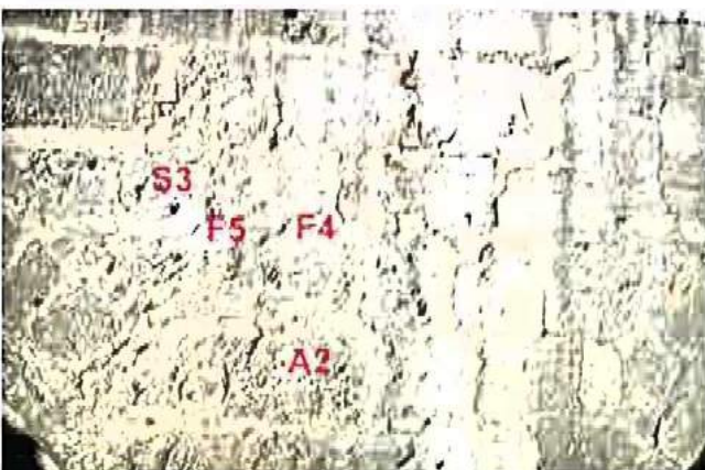
Bild A1.44: Wandfläche über dem zuvor genannten Bereich: Unter dem abschalenden zementhaltigen Mörtel („M“) wird ein Gipsmörtel, der trotz Anwitterung noch mit den Steinkanten abschließt, sichtbar.
