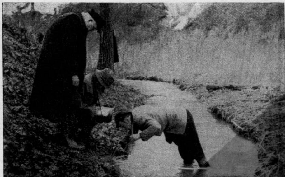
Vermessung der Zuflußmengen und Fließgeschwindigkeit des Glasebaches (Zuflußbach) zum Periodischen See.
