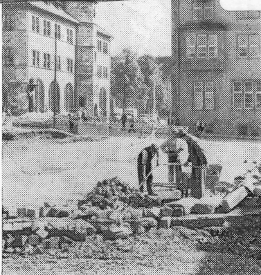
Neupflasterung des Lutherplatzes im August 1957
